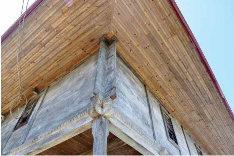
Şekil 8. Kuzeydoğu Köşesi Çantı Detayı
