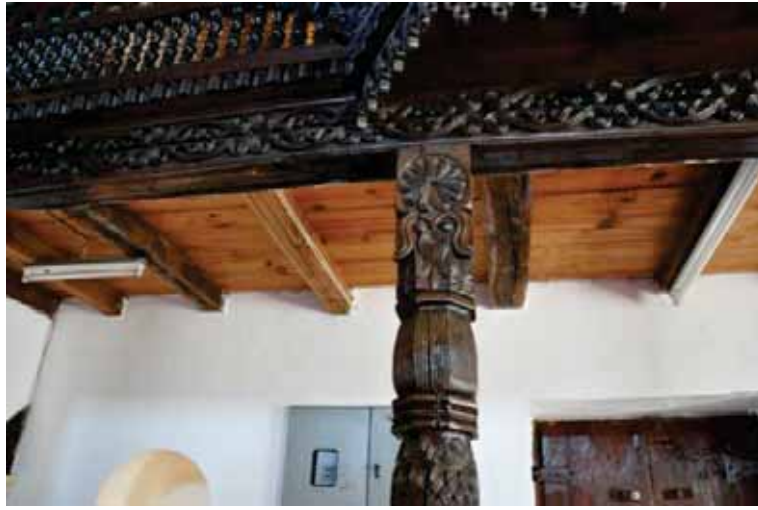
Şekil 10. Harimden Ahşap Dikme Örneği
