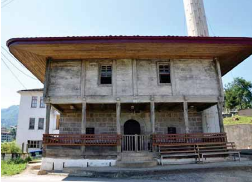
Şekil 6. Mithat Paşa Camii Giriş Cephesi
