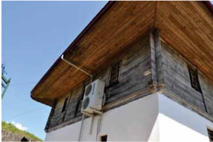
Şekil 21. Güney Cephesi, Klima, Yağmur İniş Borusu ve Sıvalı Taş Duvar
