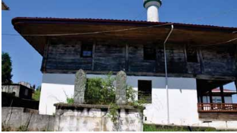
Şekil 22. Doğu Cephesi, Yağmur İniş Borusu, Elektrik Kabloları ve Sıvalı Taş Duvar
